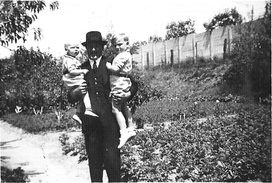
De tuin van Zandstraat 4 met rechts de betonnen schutting
